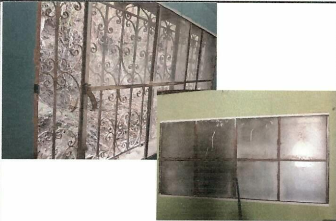
Foto 3: Cambio de 12 ventanas de metal 1*1 y 2 ventanas 2*1
