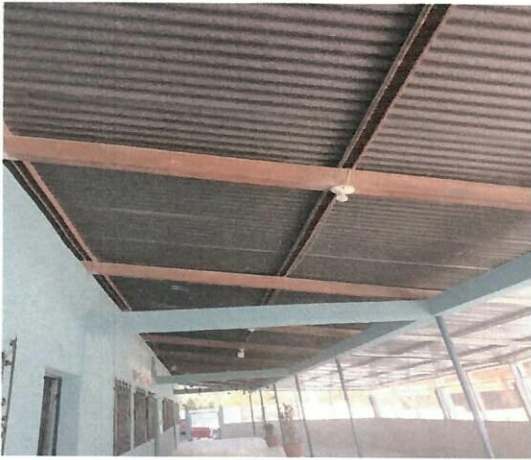
Foto 2: Cubierta de lamina calibre 26 troquelada y mantenimiento de estructura metalica de modulo de 4 aulas.
