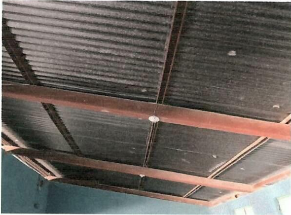
Foto1: Cubierta de lamina calibre 26 troquelada y mantenimiento de estructura metalica de modulo de 4 aulas.
